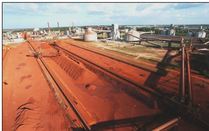
Figura 2.1 – Pátio de estocagem de bauxita da Hydro Alunorte.
