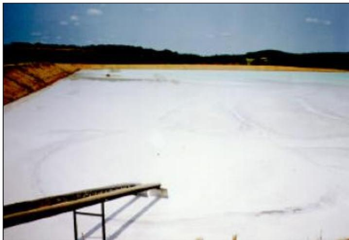
Figura 3.2: Bombeamento de efluente líquido proveniente do beneficiamento de caulim para as lagoas de sedimentação no estágio inicial.
