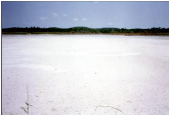
Figura 3.3: Lagoa de sedimentação do efluente industrial, após a evaporação da água excedente
